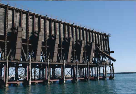
Antiguo cargadero de mineral "El Cable Inglés"
