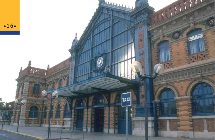
Fachada principal de la antigua estación de Ferrocarril
